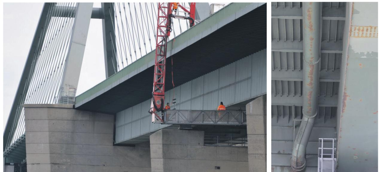
Arbeiten in luftiger Höhe über dem Fehmarnsund (l.). Die Stahlrohrleitung mit einem Durchmesser von 30 Zentimetern befördert Frischwasser vom Festland zur Insel Fehmarn.
